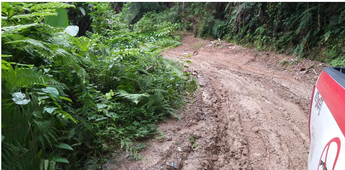
Punto crítico de la rasante de la vía
