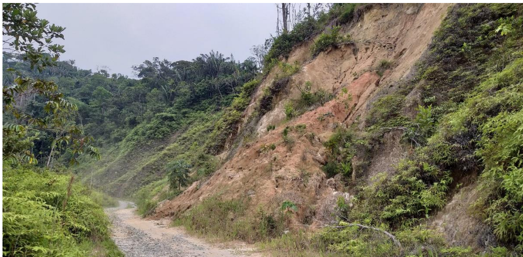
Remociones de masa en taludes inestables
