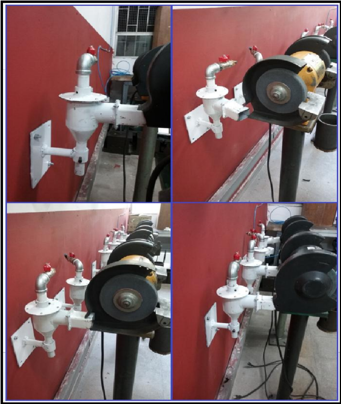
Figura 30. Instalación y acoplamiento de eyectores con los esmeriles
