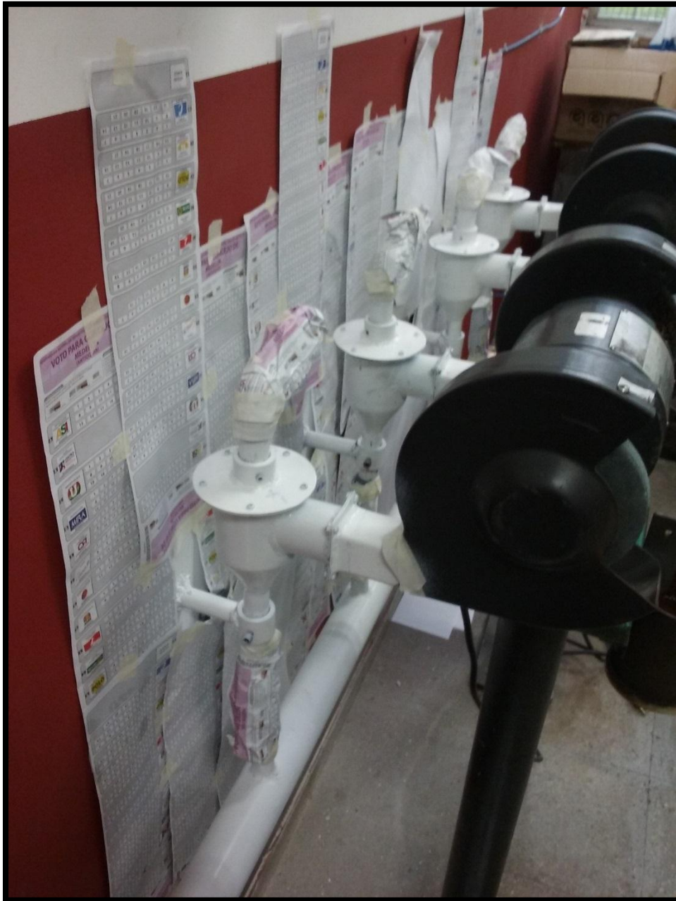
Figura 33. Aplicación de pintura al sistema ya instalado
