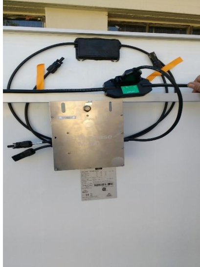
FIGURA 22. Elementos de conexión.
