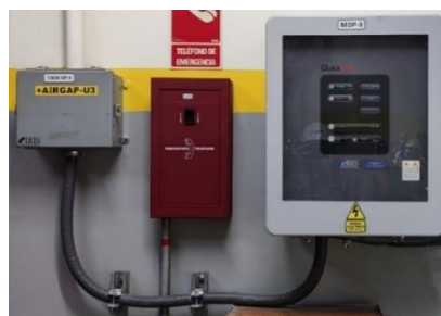
Figura 20 Equipo de monitoreo de descargas parciales GuardII+
