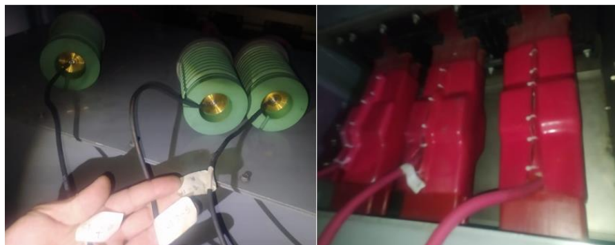
Figura 32 Instalación de acopladores capacitivos en generador de la central térmica N.1.
