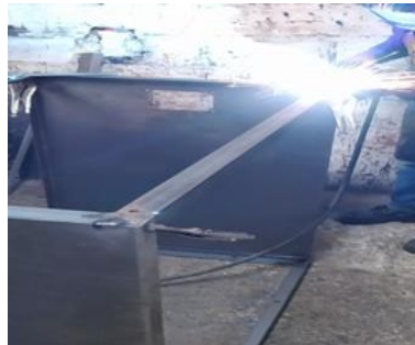
Armado con soldadura
