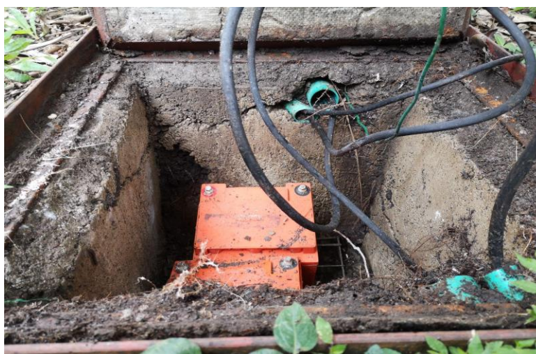
Figura 10. Inspección de cables actualmente instalados en microrred existente. Fuente. Propia
