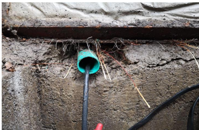
Figura 9. Revisión de tubería existente. Fuente. Propia
