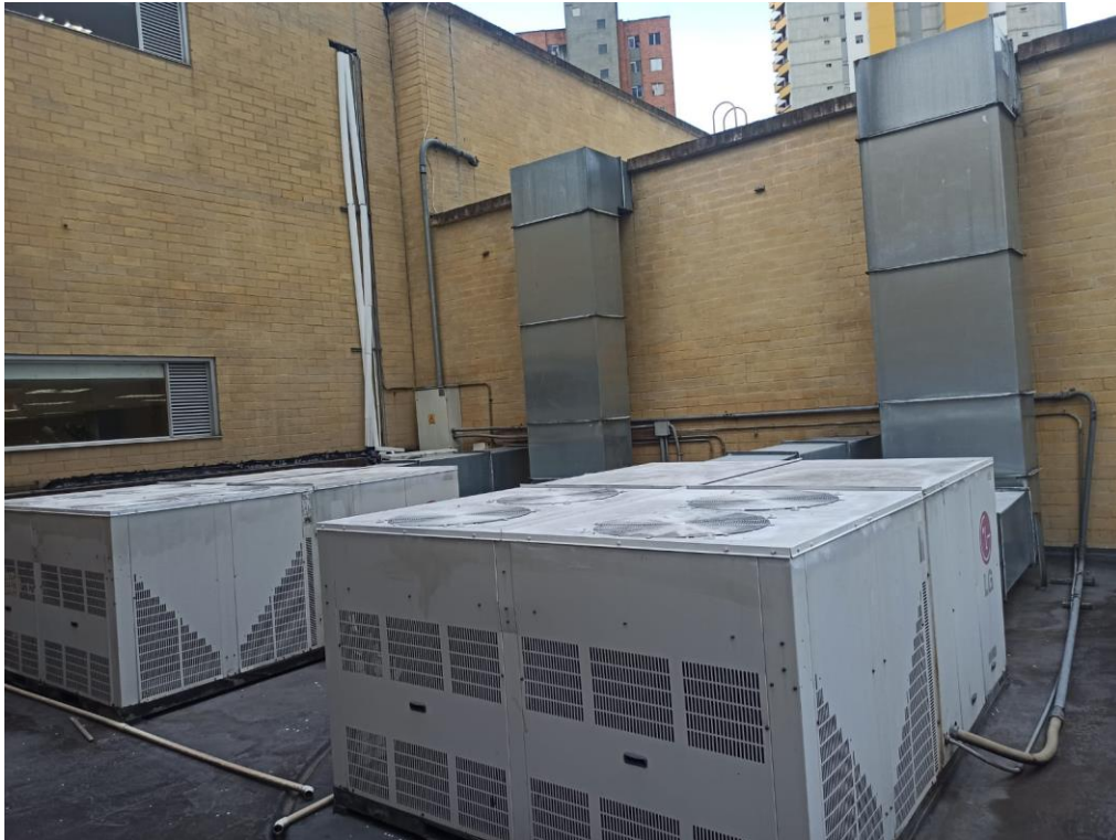
Figura 18. Equipos de A.A tipo paquete sencilla Fuente: propia
