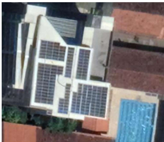
Figura 26. Paneles solares bloque 6. Fuente: https://pascualbravo.edu.co/
