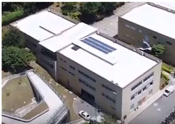
Figura 21. Paneles solares bloque 25.
