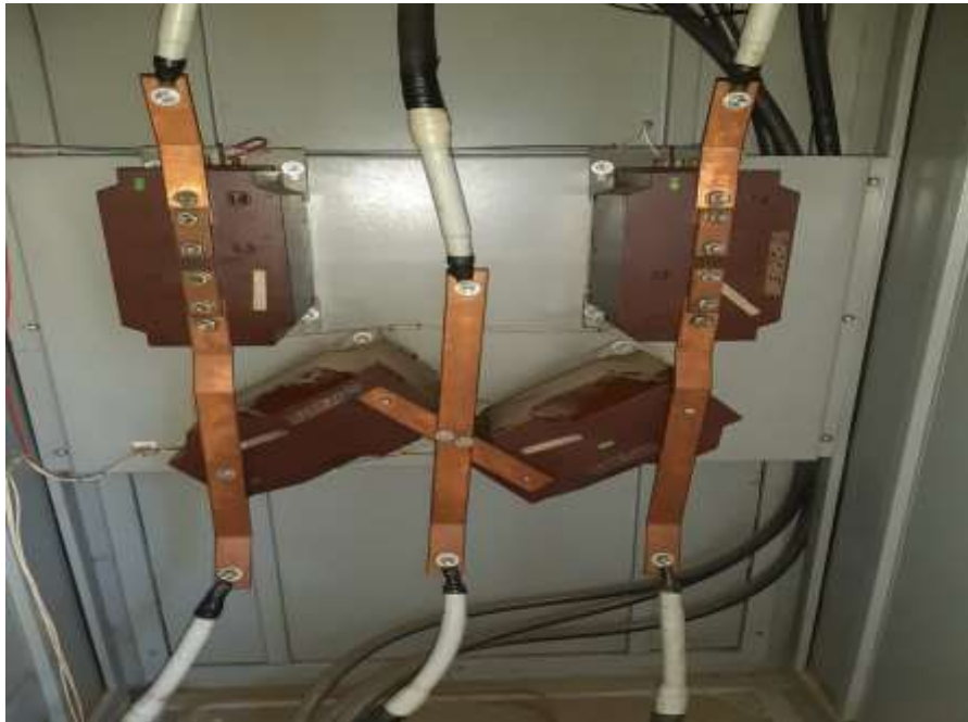
Figura 11. Transformador de potencia.
