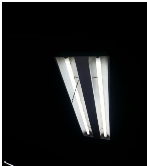
Ilustración 3 Luminarias en mal estado
