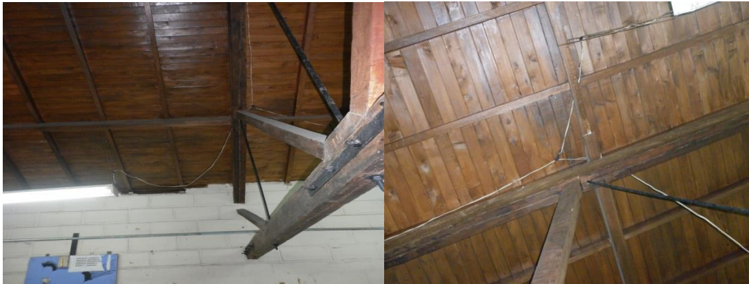
Ilustración 5 Cableado expuesto
