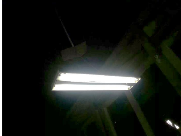
Ilustración 4 Sujeción deficiente
