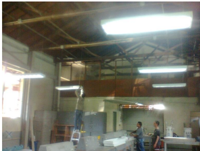
Ilustración 13 Proceso de Instalación
