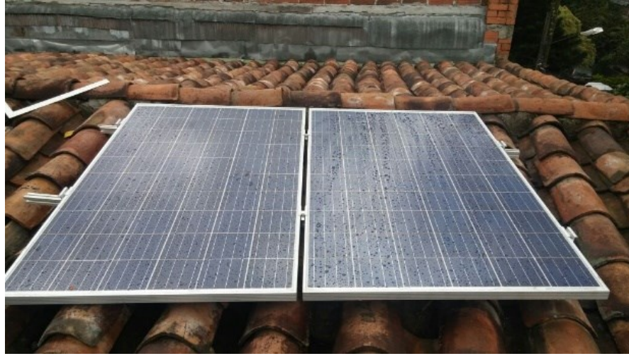
Foto 1. Paneles solares instalados en techo de la empresa Pizzelino
