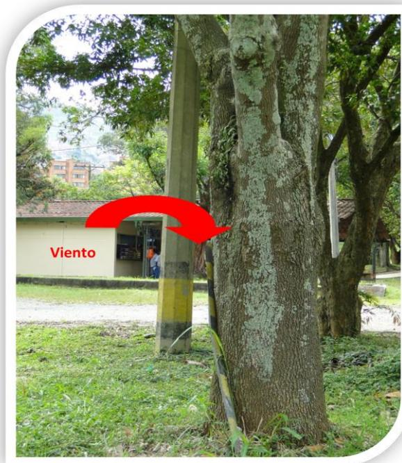
**Figura 3.** Viento que sirve para equilibrar las fuerzas mecánicas de las estructuras primario convencional sometido a tensión por el tallo de un árbol.
