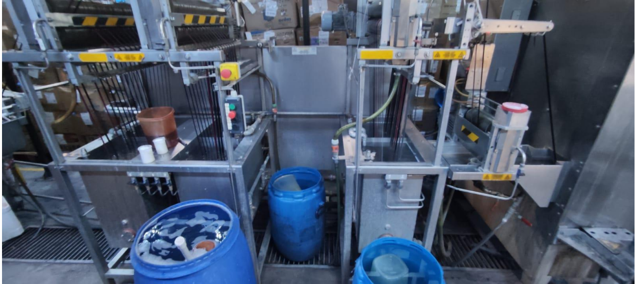
Ilustración 15 Zona de Tintorería PROSALTEX S.A.S.
