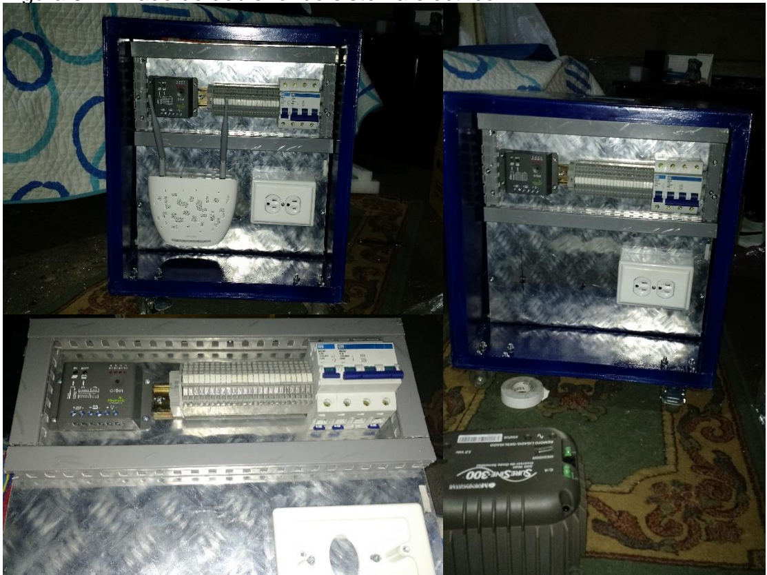
Figura 9 Armado de doble fondo sistema eléctrico.
