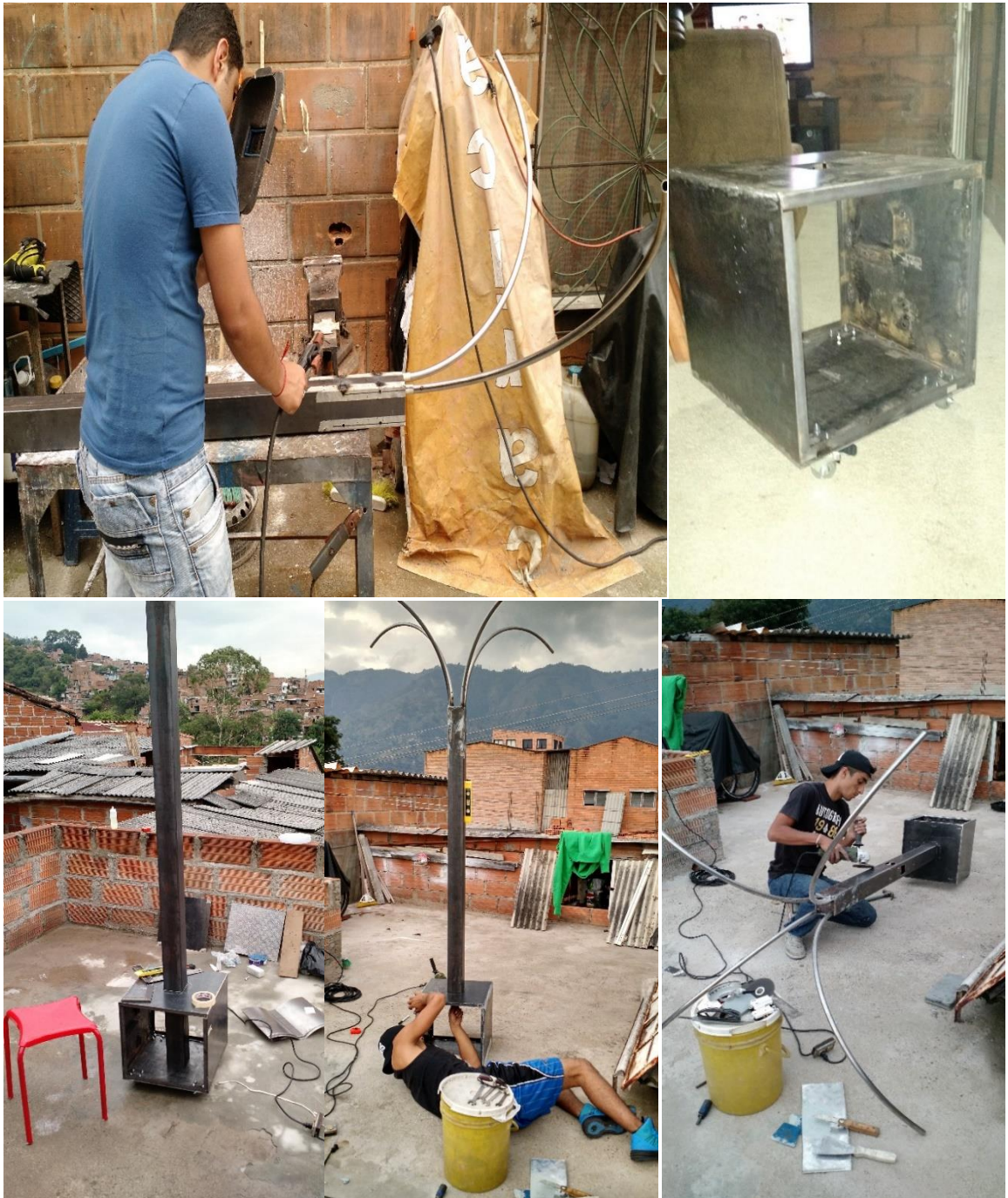
Figura 7 Construcción y ensamble de estructura metálica
