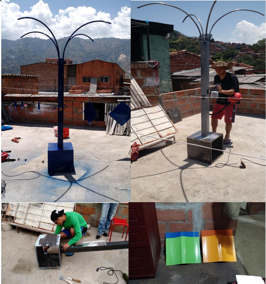
Figura 8 Acabado y pintura.
