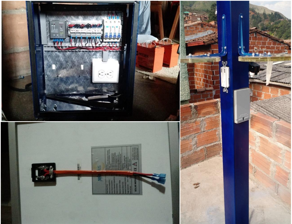
Figura 11 Cableado y montaje de suicheria del modulo
