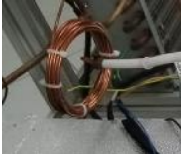
Ilustración 3. Capilar Elaboración propia del autor
