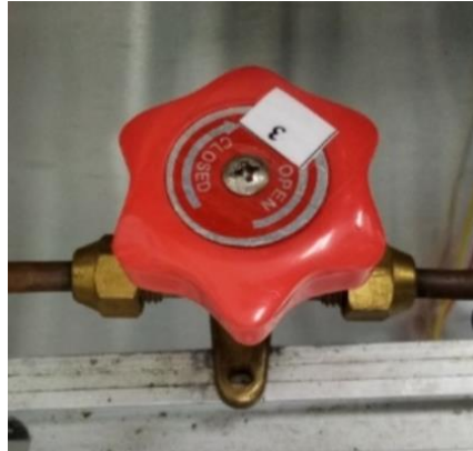
Ilustración 5. Válvula de corte Elaboración propia del autor
