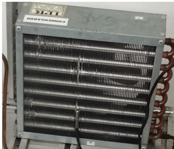
Ilustración 2. Condensador
