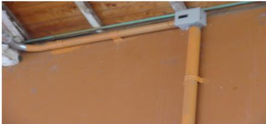
Figura 19. Instalación final de tubería.
