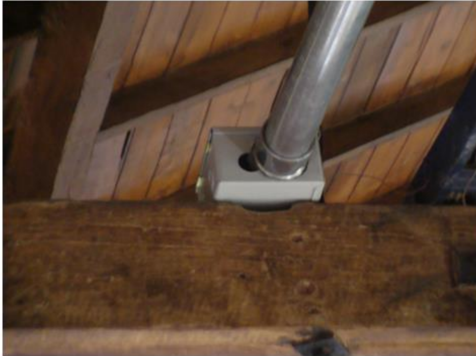
Figura 14. Instalación de cajas.
