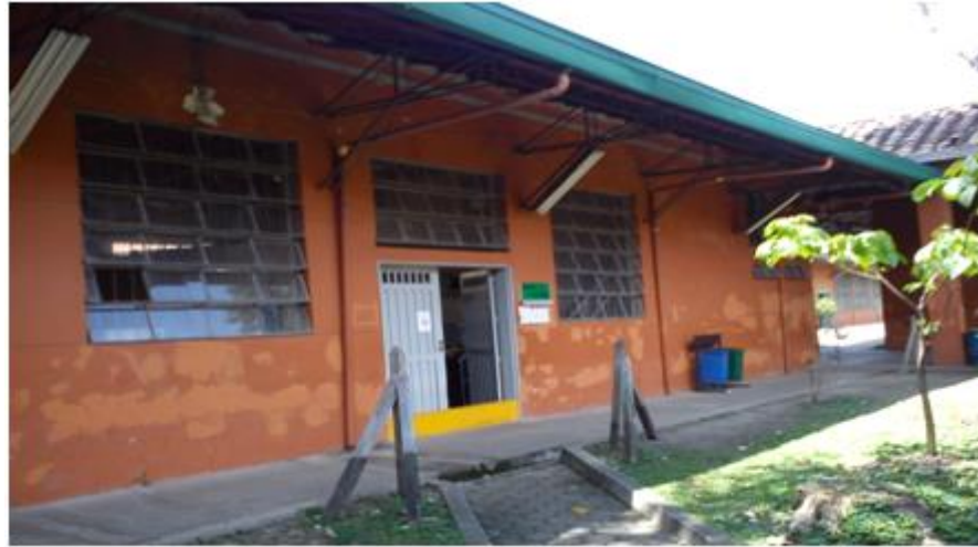
Figura 12. Laboratorio de máquinas 1 bloque 4D aula 101.
