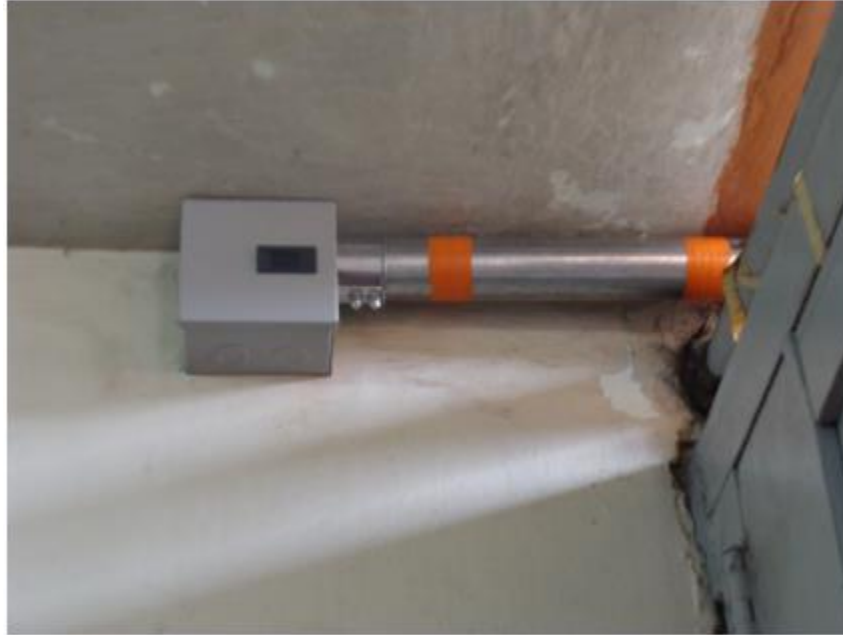
Figura 21. Instalación final de tubería.
