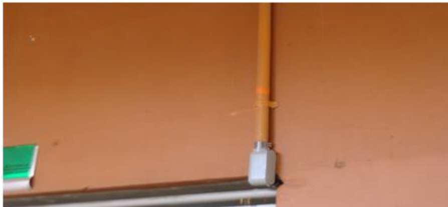
Figura 20. Instalación final de tubería.
