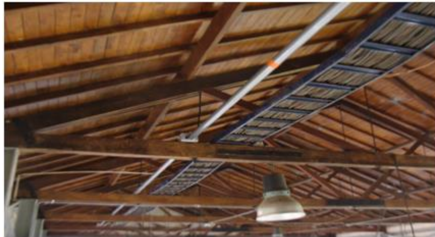
Figura 17. Instalación de elementos varios para unión de tubería.
