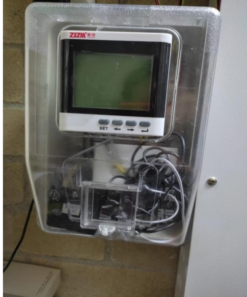
Figura 10. Instalación módulo de medición
