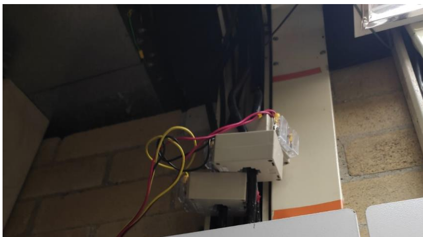
Figura 11. Instalación transformadores de corriente
