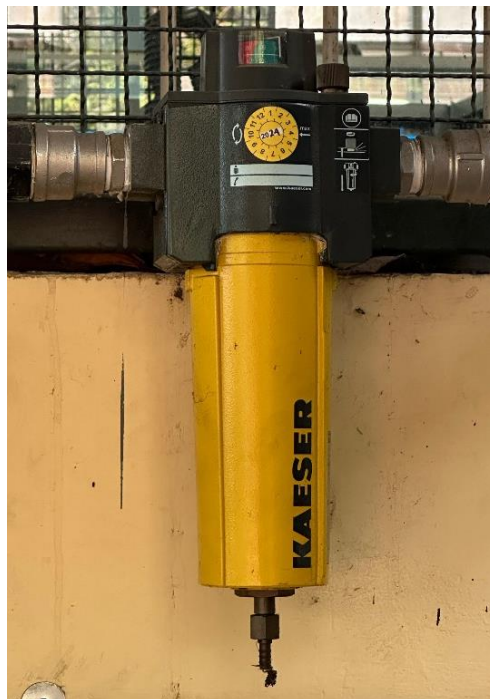
Figura 10 Unidad de mantenimiento - Filtro de línea F16KE de Kaeser.
