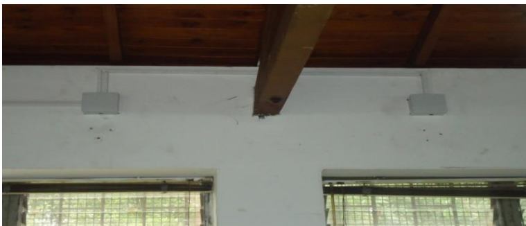
Figura 15. Cajas protectoras y canaleta nueva.
