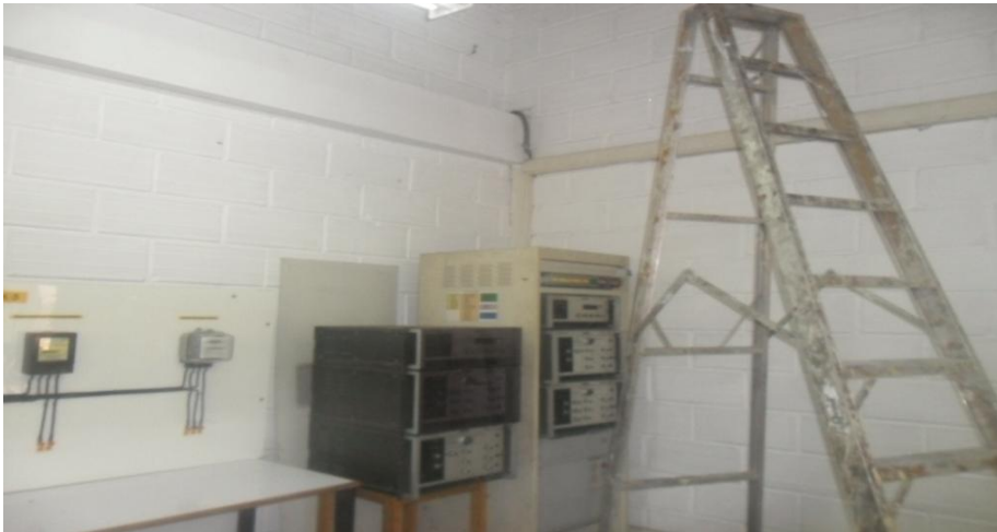
Figura 14. Estado inicial donde fue colocado el tablero de circuitos del salón 3A-109
