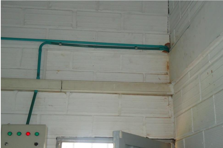
Figura 16. Canaleta existente en el salón.
