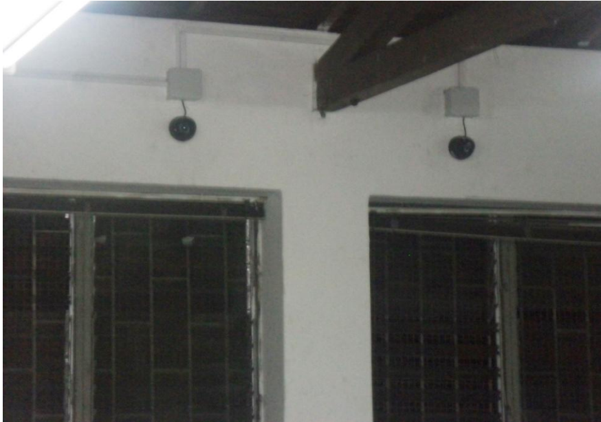
Figura 22. Cámaras 3 y 2 respectivamente.
