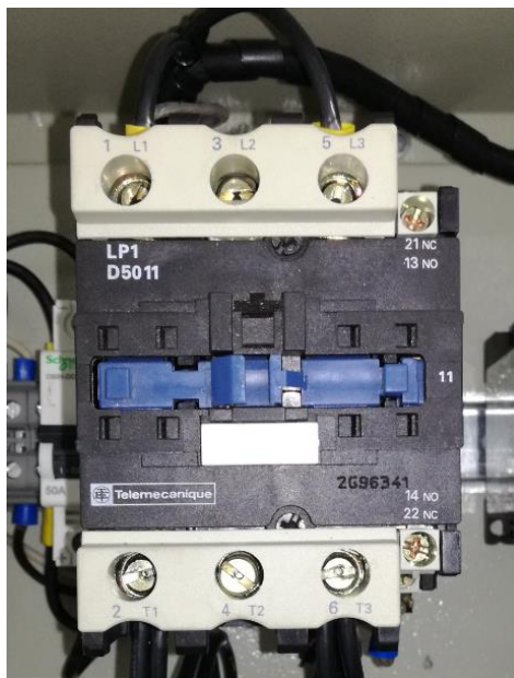
Ilustración 23. Contactor 50 A 24 VDC Telemecanique
