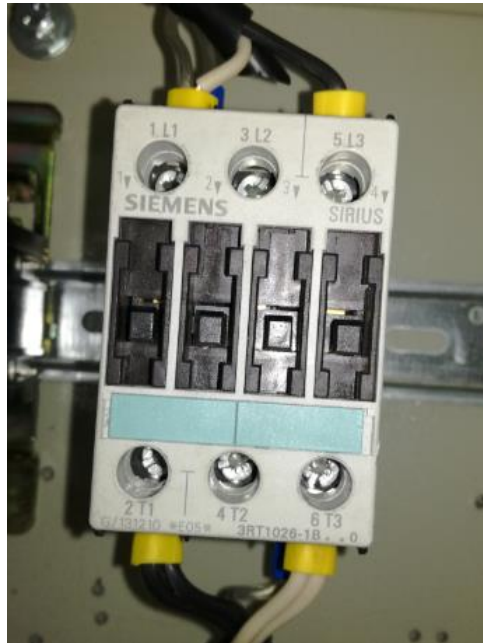
Ilustración 24. Contactor 25 A 24 VDC SIEMENS
