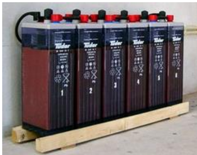
Ilustración 13. Batería estacionaria transparente (ingenierosgema@gmail.com, 2012)
