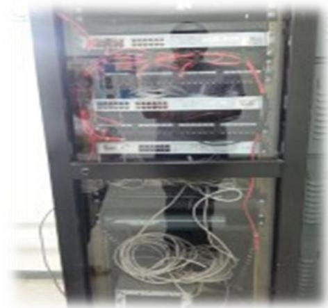
Figura 10. Rack con switches de comunicación.
