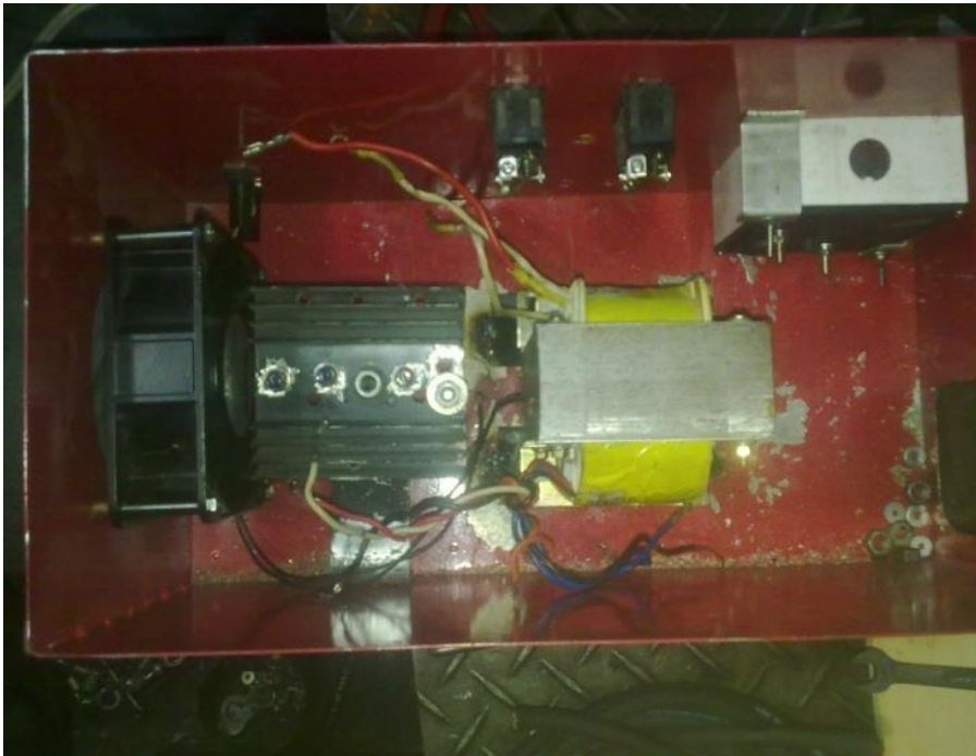
Ilustración: Montaje del transformador con el dissipador de calor
