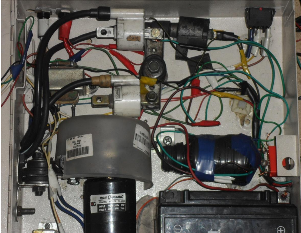
FIGURA 10. ESTRUCTURA Y CABLEADO INTERNO
