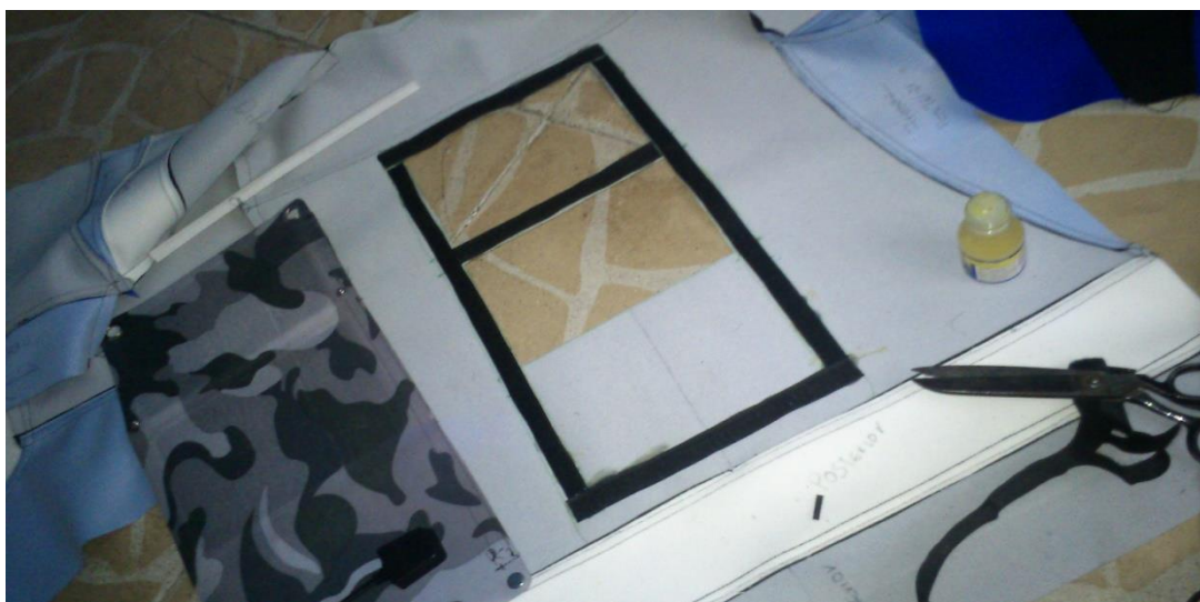
Foto 21 instalación panel solar
