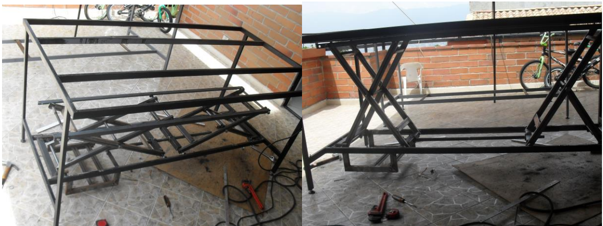
Figura 63 Verificación del funcionamiento de las tijeras
