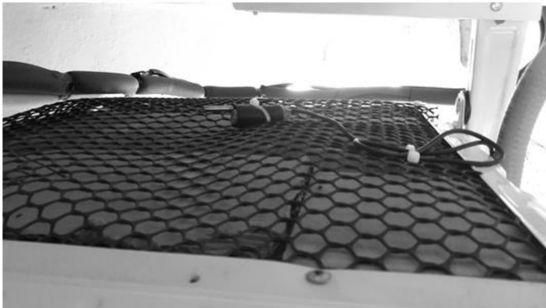
Figura 5-8 FILTRO OBSTRUIDO UNIDAD CONDENSADORA
