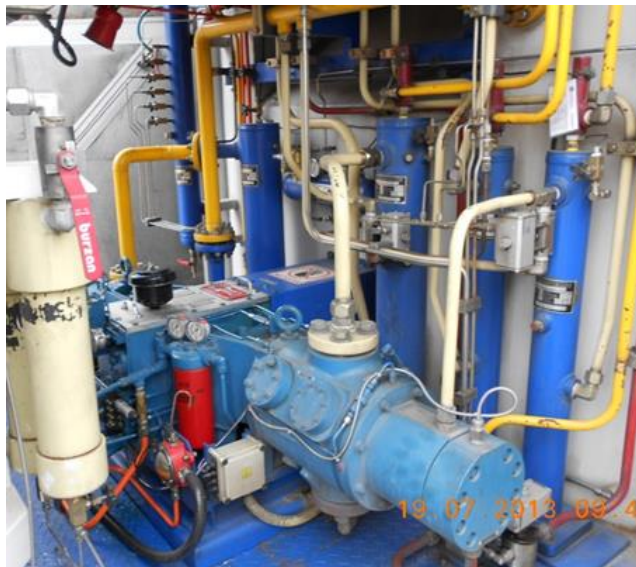
Figura 3. Compresor recíprocante tipo Tándem de 4 etapas marca Ariel (Tomada en la EDS de Belén, 2013) EDS Belén
