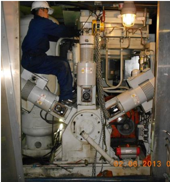
Figura 4. Compresor recíprocante cilindros en V Marca IMW de 3 etapas (Tomada en la EDS de Exposiciones, 2013) EDS Exposiciones
