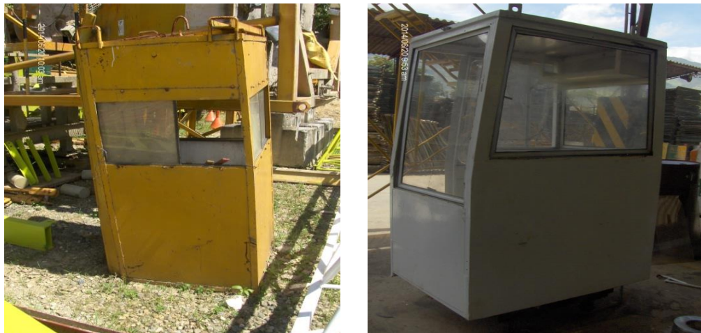
Figura 7. Cabinas de control. Imagen tomada en el sitio (2014).
