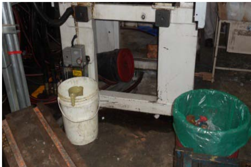
Figura 9. Vista 10. Planta inyección RIMO.
