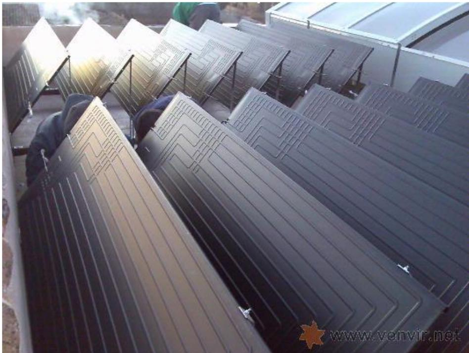
Figura 5. Panel solar termodinámico
