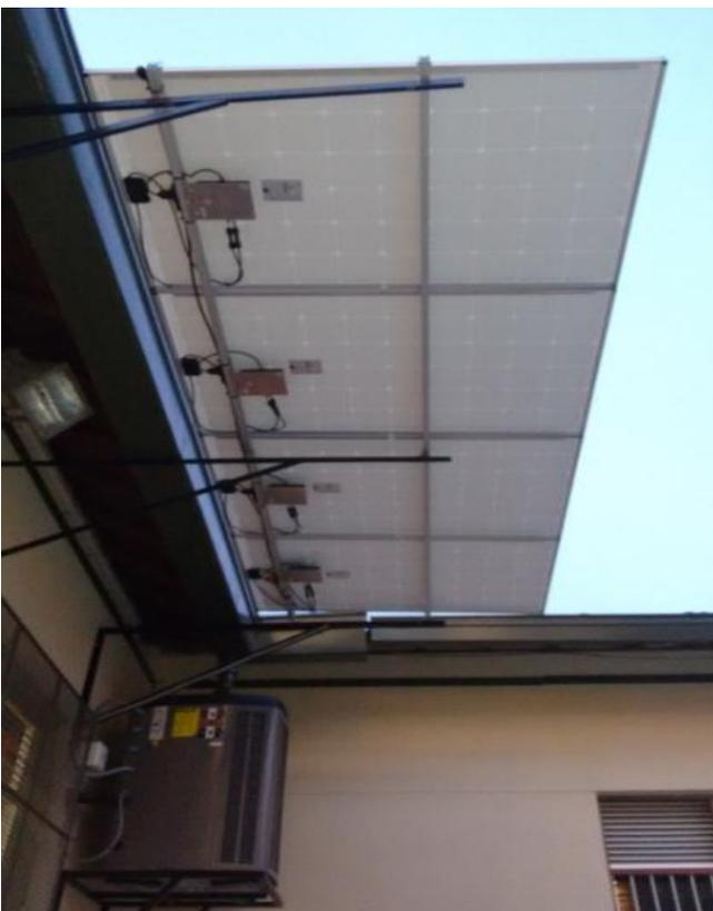
Ilustración 6. Sistema solar fotovoltaico Híbrido en la IUPB.
