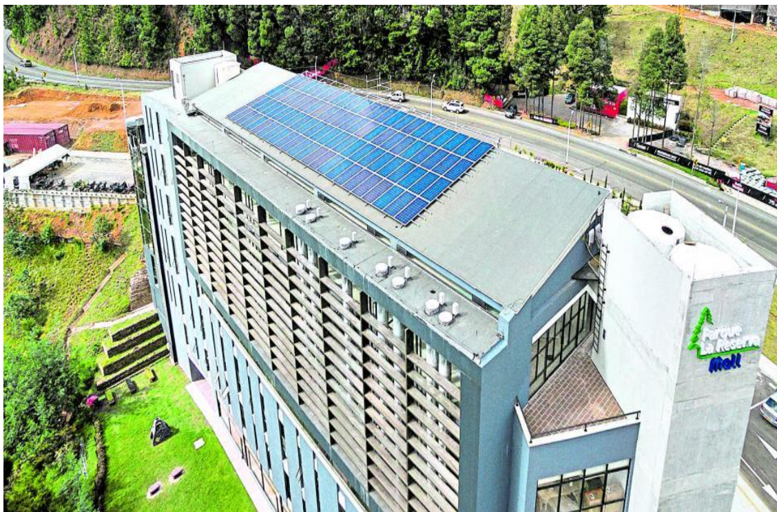
Figura 3. Instalación del techo solar.
