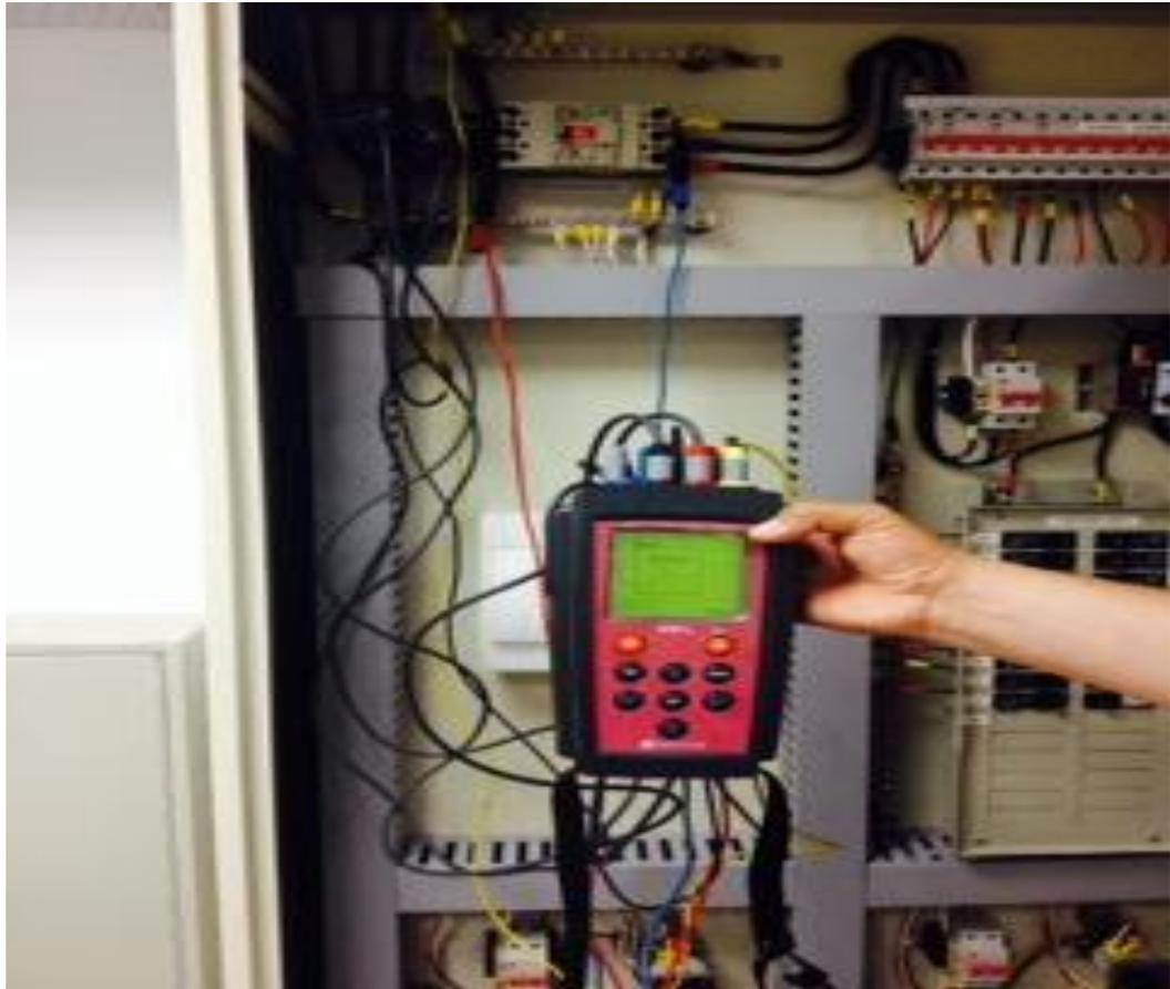
Figura 33: Conexión del AR5-L<sup>71</sup>.
