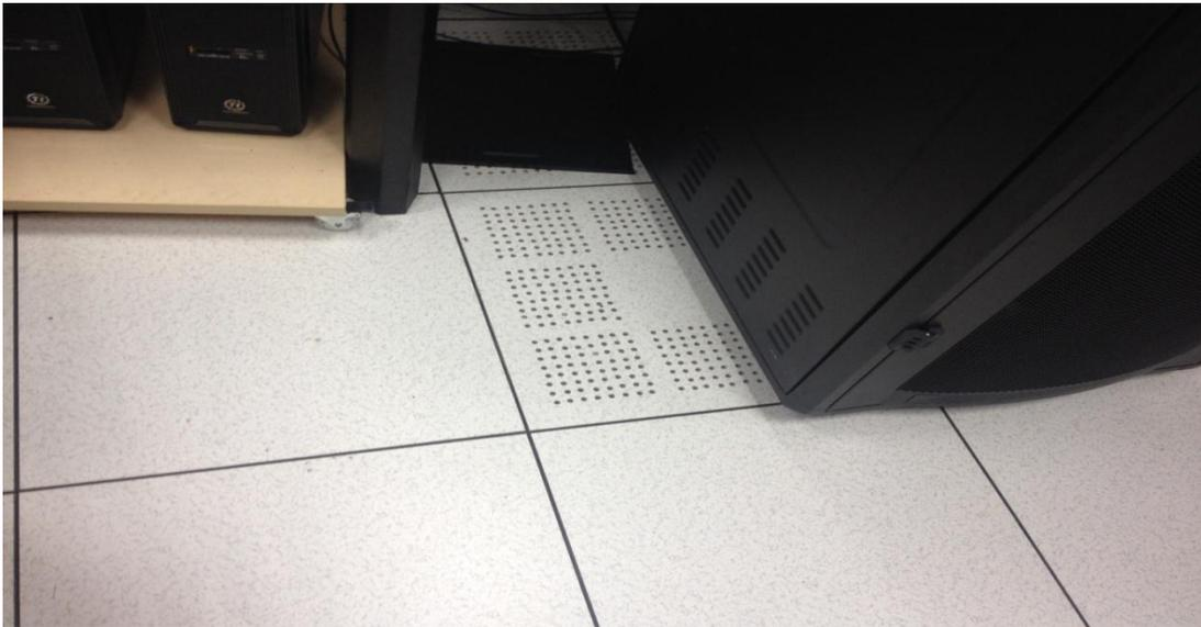
Figura 13: Piso técnico con corredores fríos y calientes<sup>53</sup>.
