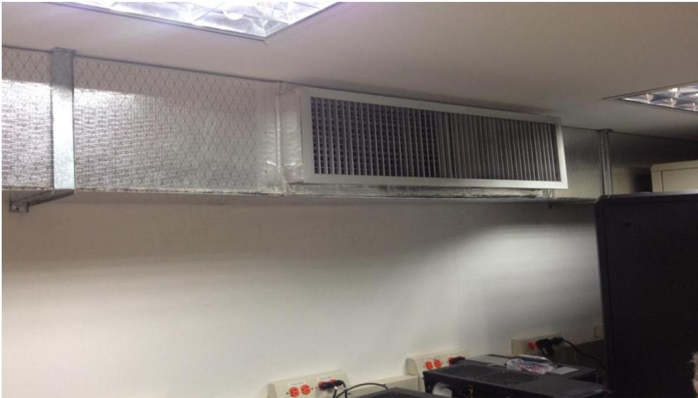
Figura 28: Conductos de A.A con rejilla difusora.<sup>65</sup>
