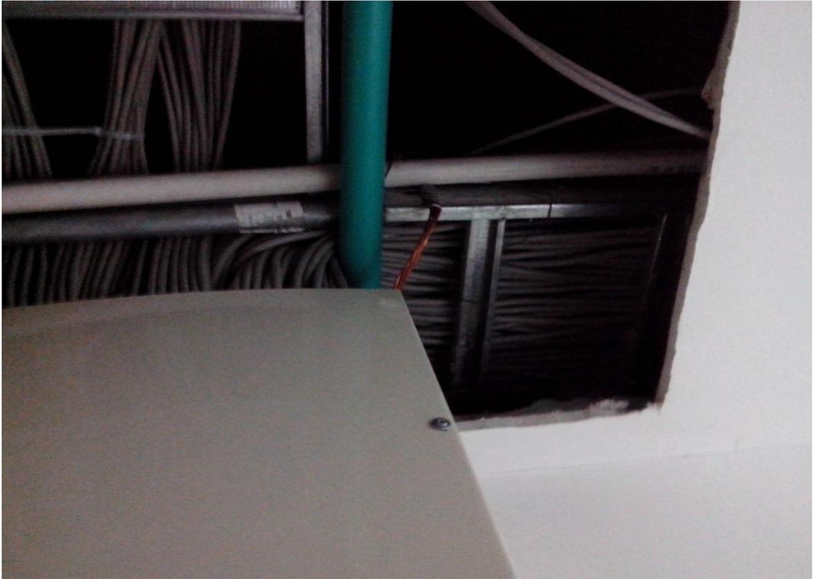
Figura 25: Bandejas portacables aterrizadas<sup>63</sup>.
