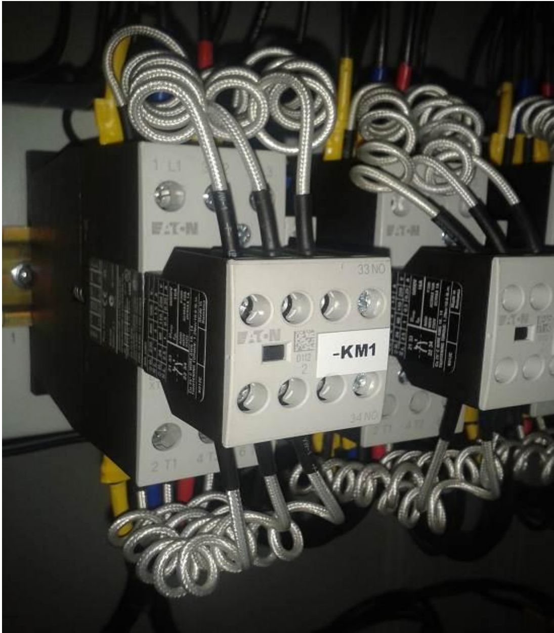
Figura 8 11 .Contactor con resistencias de pre-inserción.
