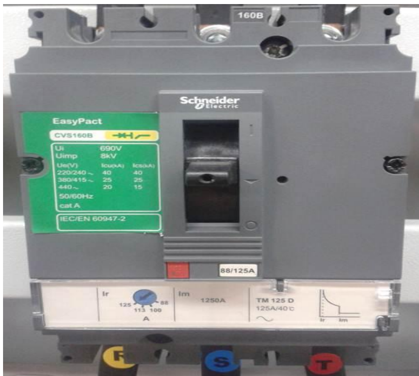
Figura 9 15 . Breaker de Protección General.
