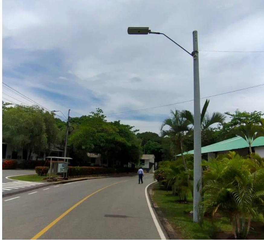
Figura 19. Iluminación tipo unilateral (LED2), Carrera 46 El Bagre.
