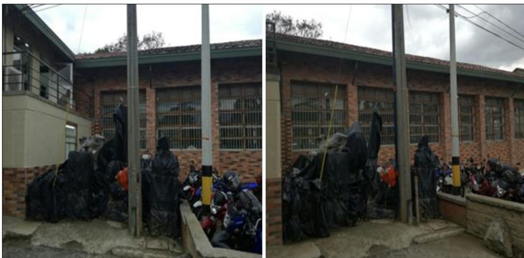
Figura 6-35. Zona elegida para la ubicación de subestación proyectada.
