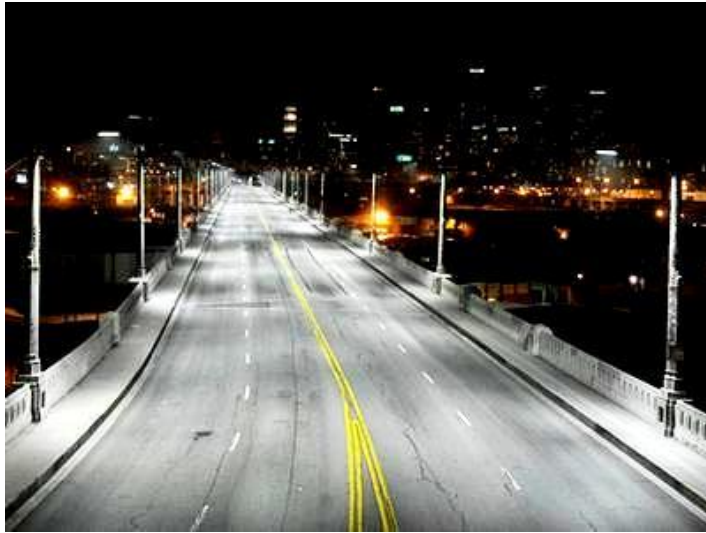
Figura 17. Autopista 1 con luminarias tipo led.
