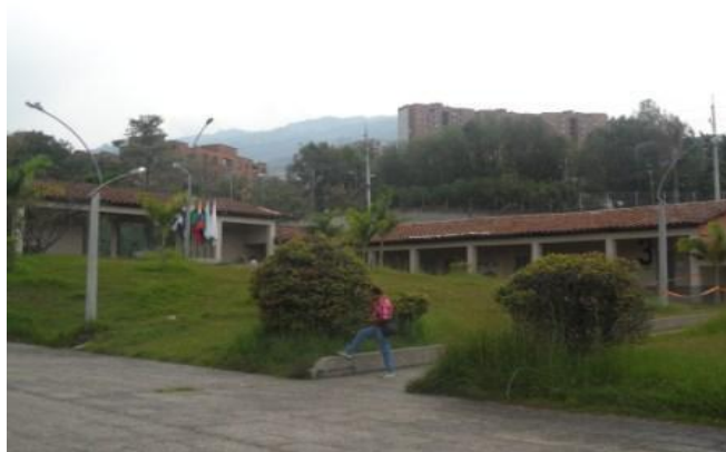
Figura 21. Área de influencia del proyecto con luminaria tipo LED Bloque 3A
