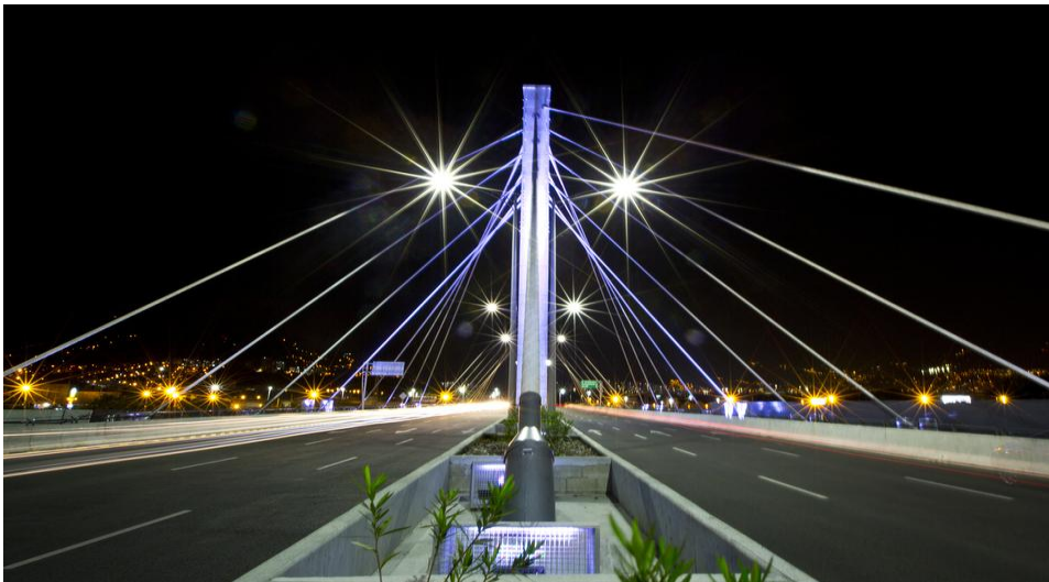
Figura 30. Iluminación sector salida lateral del bloque 3A del fotografía tomada a las 8:30 pm.
