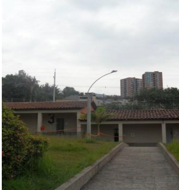
Figura 22. Detalle de luminaria de corredor peatonal Bloque 3A
