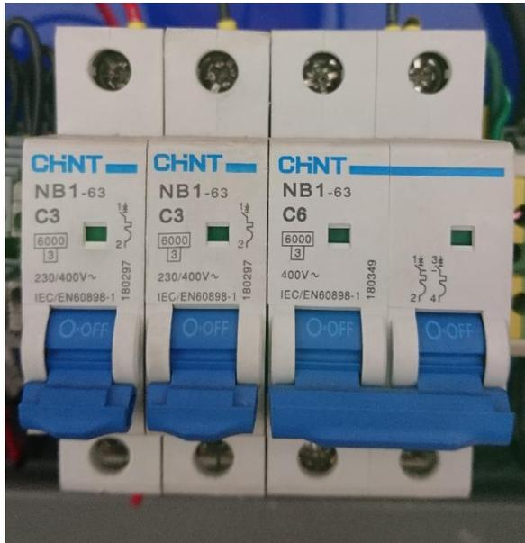
Figura 32 Braker usado en la construcción del Módulo de Control.
