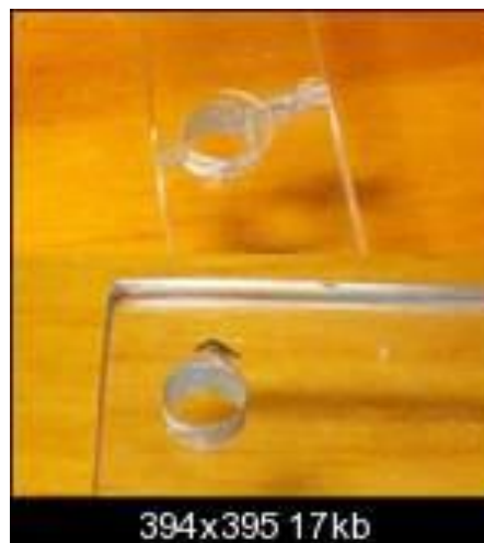
Figura 5. Perforaciones en gabinete 20
