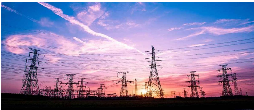
Figura 2. Torres de transmisión eléctrica
