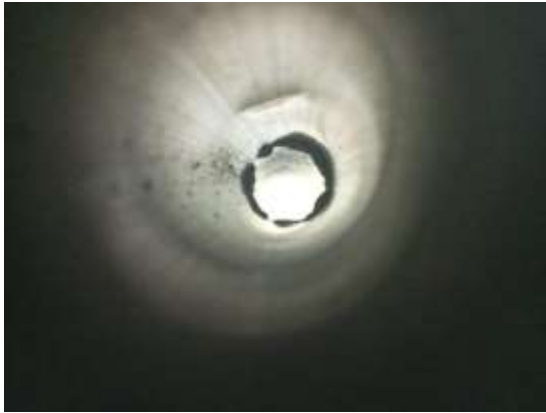
Figuras 16-10 Ensayo de soldadura (vista interior)
