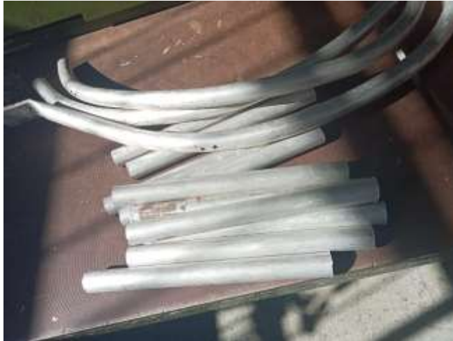
Figuras 16-5 Corte de tubería
