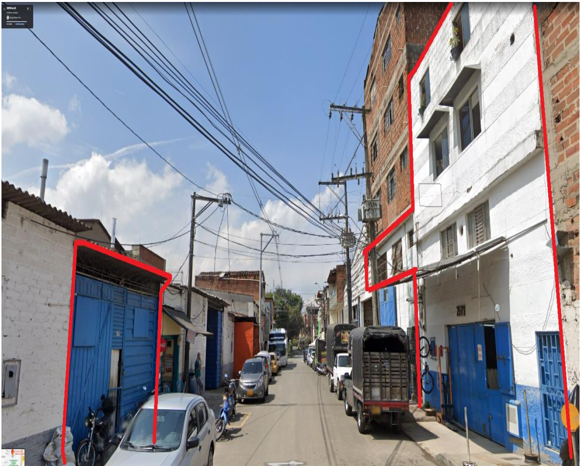
Ilustración 3 Infraestructura exterior de INCAMET S.A.S
