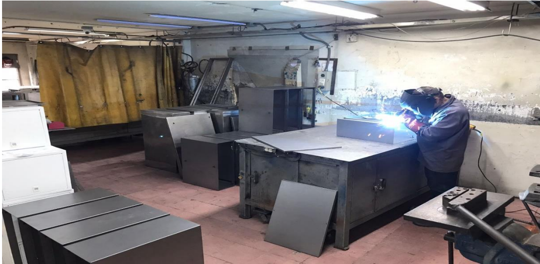
Ilustración 29 Zonas de soldadura MIG de subestaciones eléctrica.
