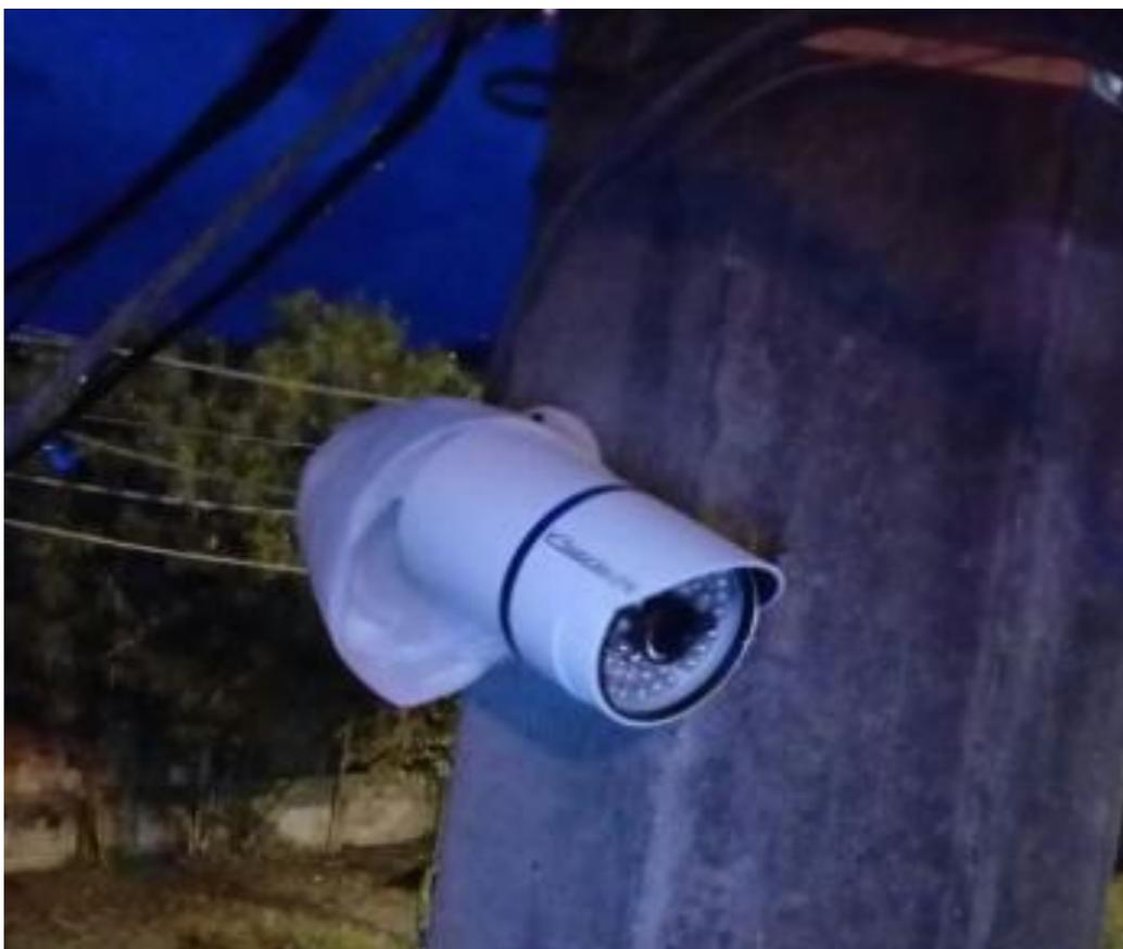
*Foto 5.* Cámara tipo bala instalada en poste.
