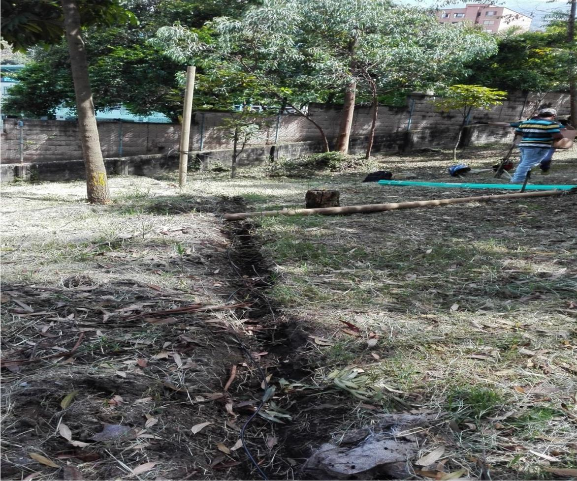
*Foto 6. Zanjas e instalación de tubería en linderos con el ITM.*
