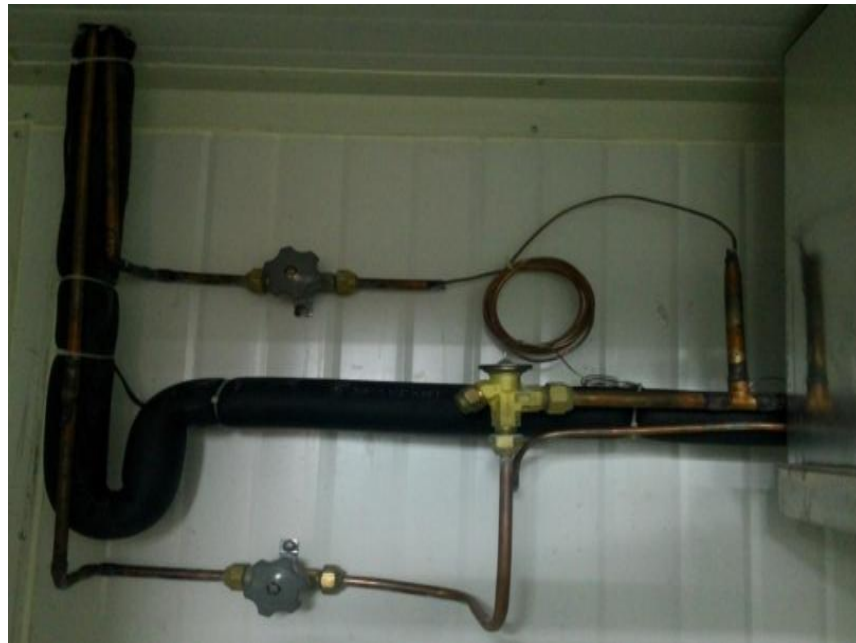
Figura 22. Montaje Líneas de Aspiración, Líquidos y Eléctrica.
