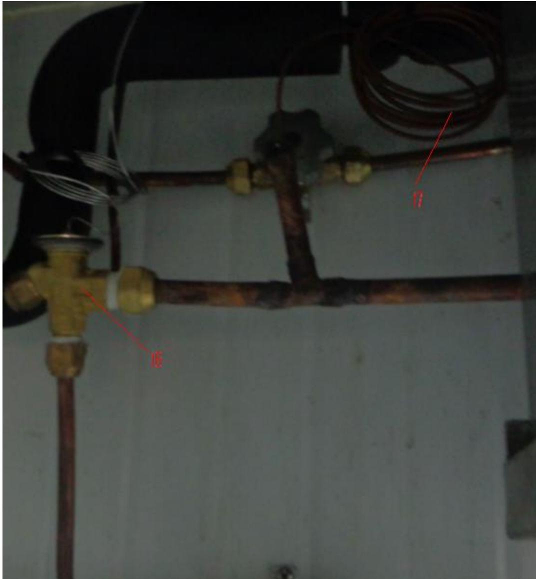
Figura 11. Capilar y válvula de estrangulamiento
