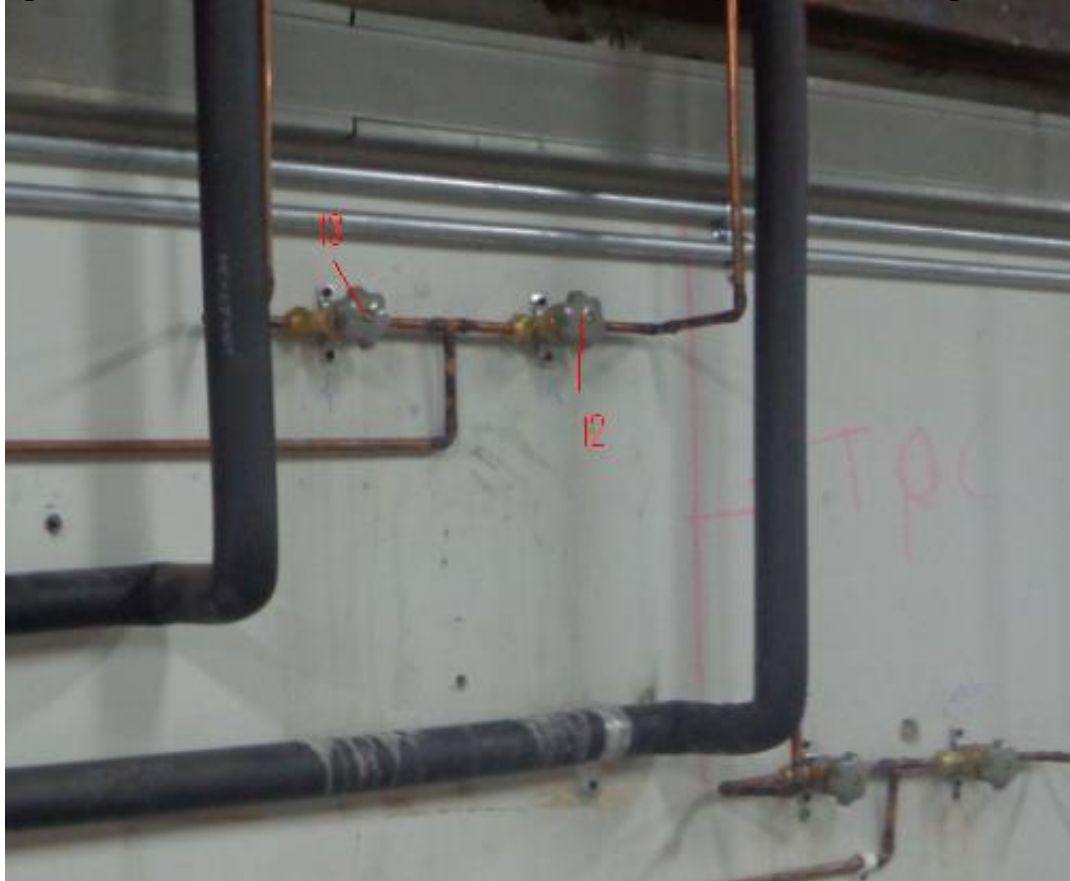
Figura 9. Válvulas manuales de selección de expansor del refrigerante
