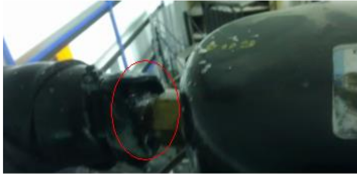
Figura 10. Prueba de fugas
