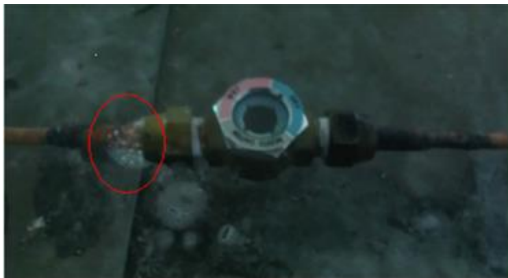
Figura 9. Prueba de fugas
