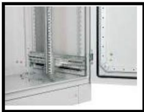
Figura 25. Fijación de una canaleta a un tablero
