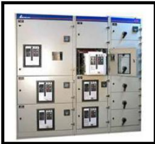
Figura 12. Fijación de interruptores a los Tableros
