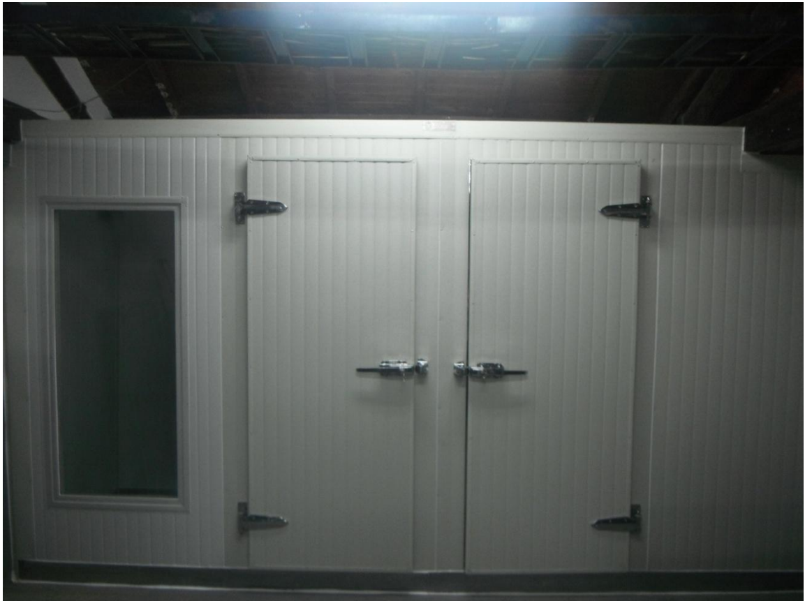
Figura 5. Vista exterior cuarto de refrigeración.
