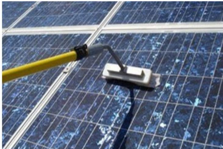
*Figura 2. Limpieza de paneles*
