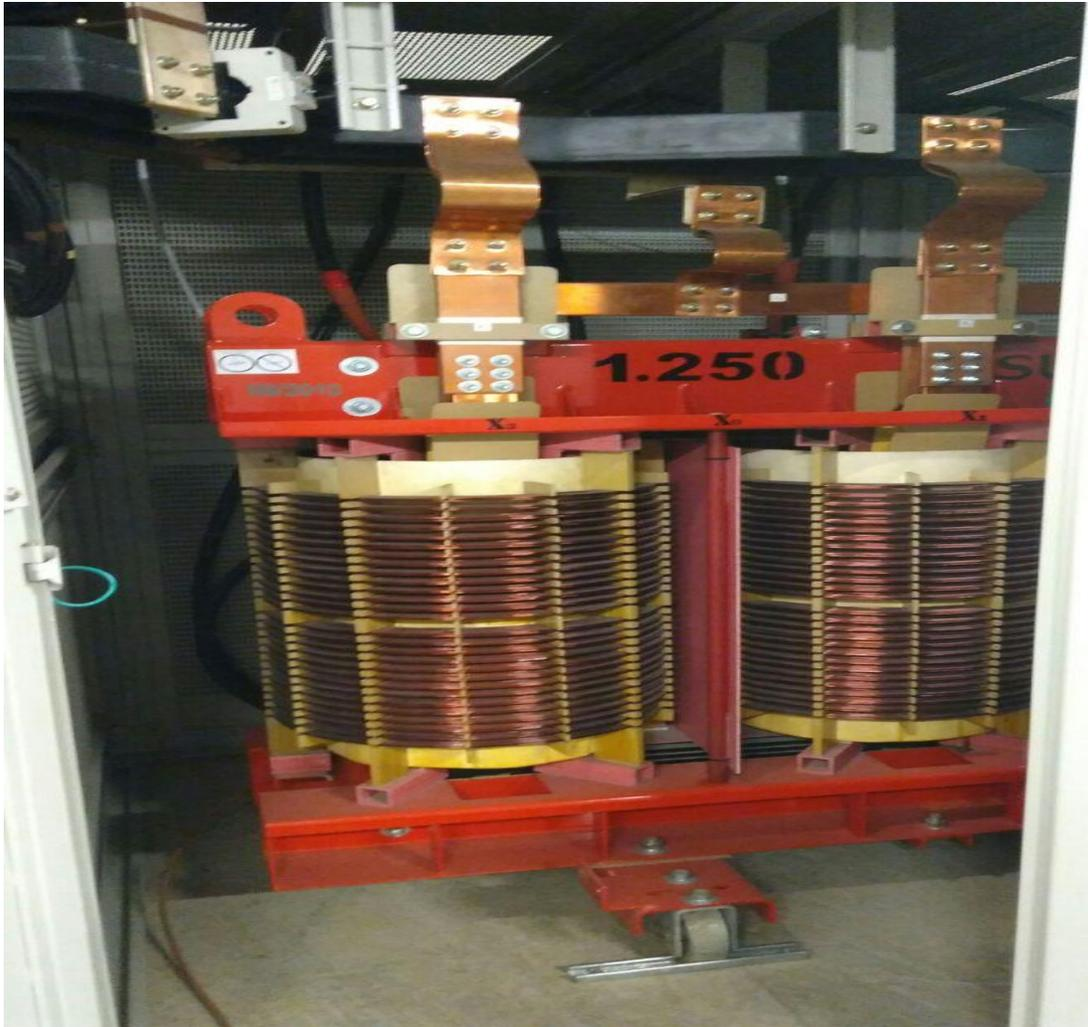
*Ilustración 2* Transformador 1250 kVA (13,2 kV-480 V)
