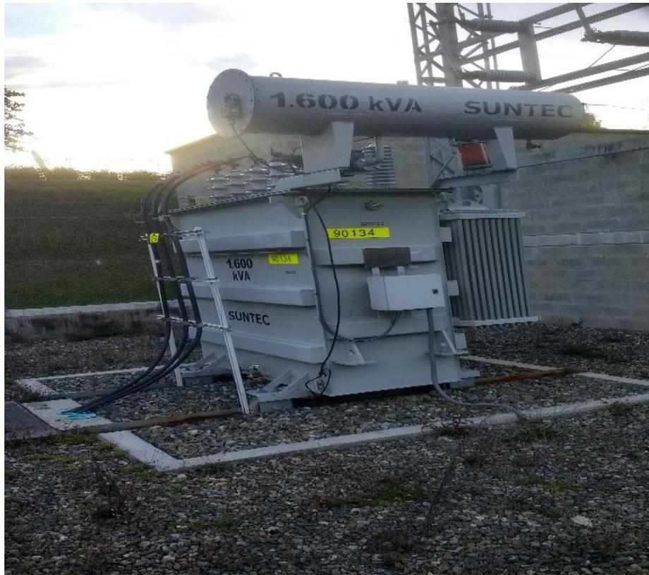
*Ilustración 1* Transformador 1600 kVA (44 kV – 13,2 kV)
